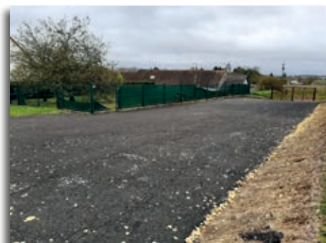
AGRANDISSEMENT DU PARKING DES ENSEIGNANTS
