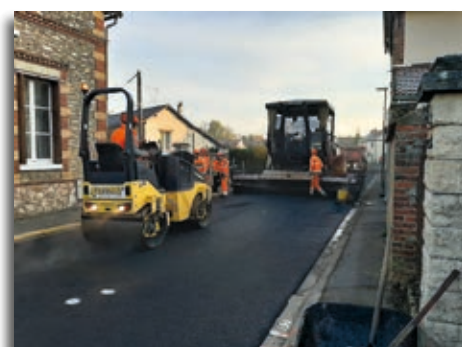
MISE EN ENROBÉ RUE DU PATY
