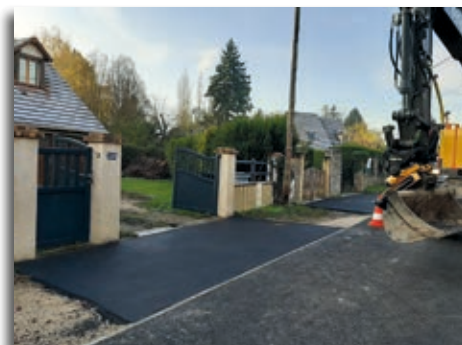
ENTRÉES CHARRETIÈRES RUE DE LA PRAIRIE
